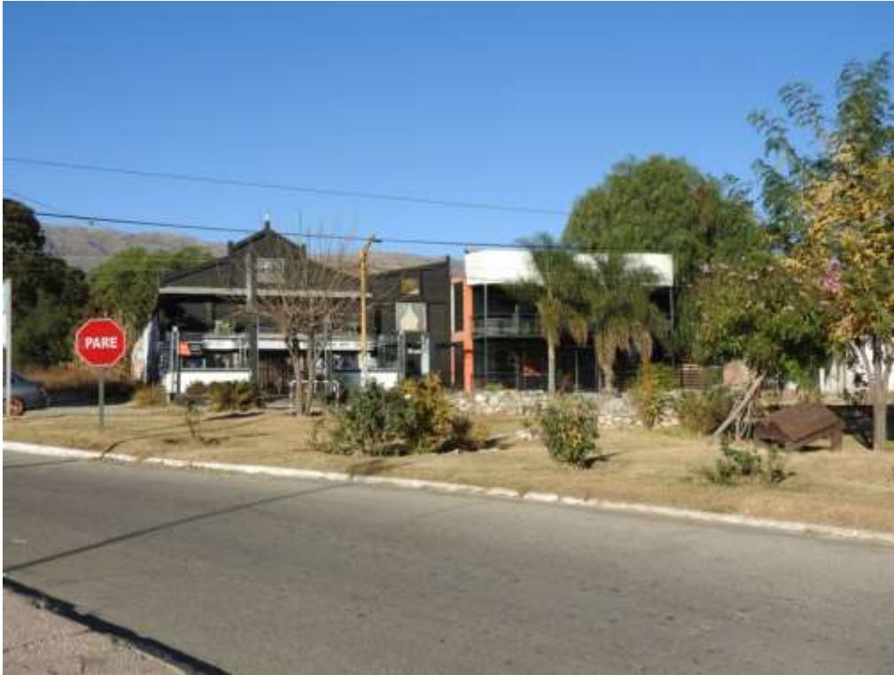
Foto 3 – Rotonda de acceso a Merlo, toma hacia el sureste. (Fotografía propia, junio 2020)
