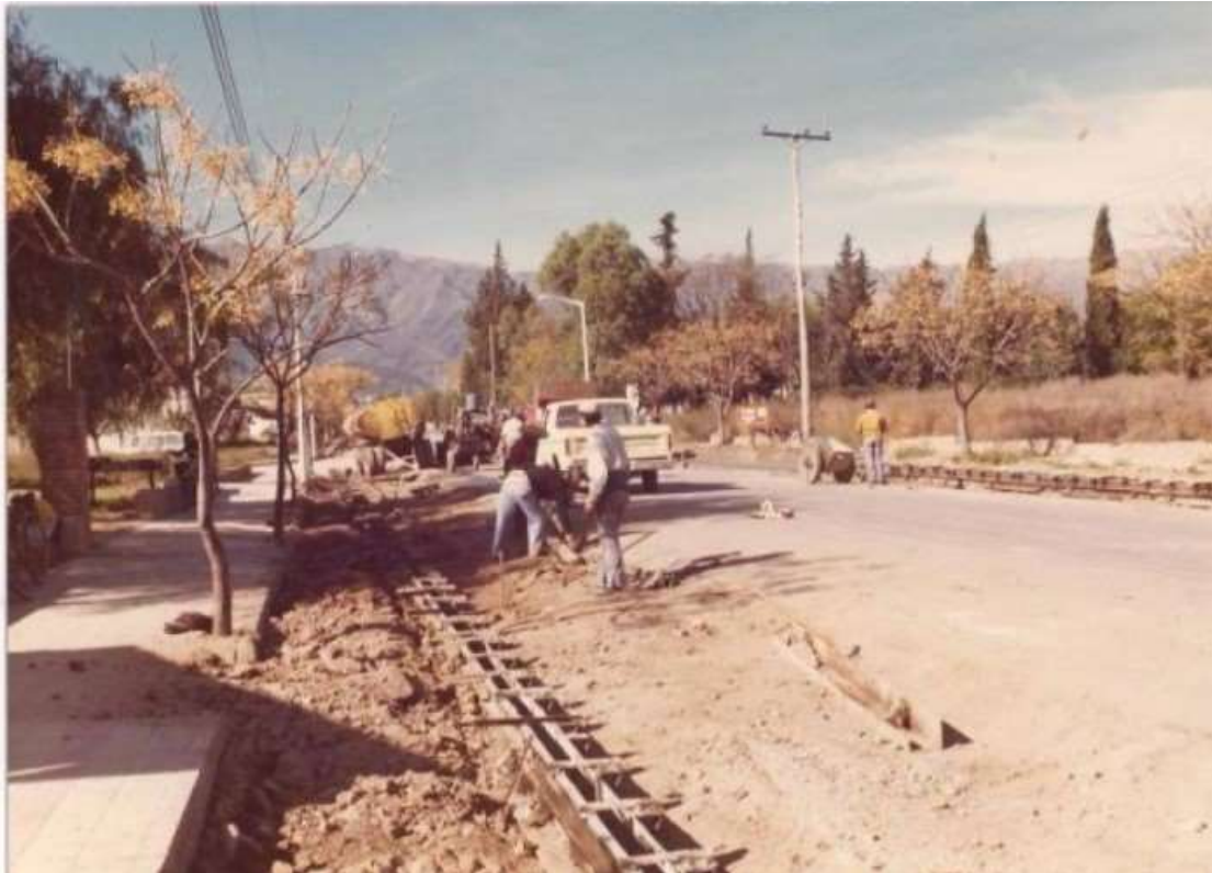
Foto 5- Imagen del ensanchamiento de la Av. del Sol – Diario digital Infomerlo (Publicación viernes 12 de abril del 2019)
